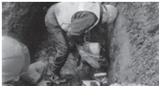
漏水箇所での復旧工事
