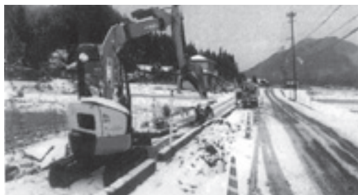
雪の中の復旧現場
