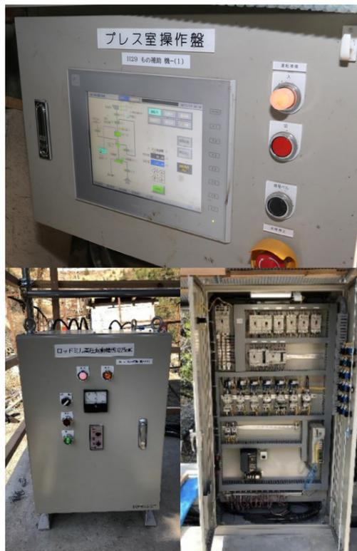
プラントに設置された制御盤は事務所で遠隔操作できる
